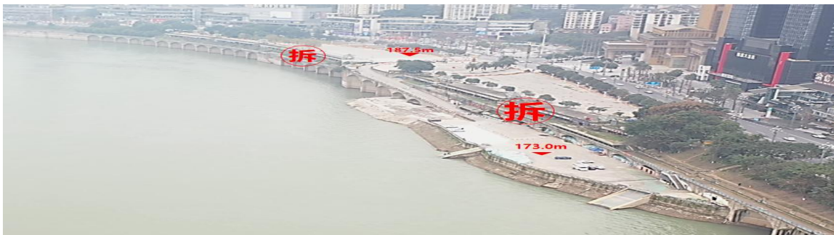
图 2.2-3 海棠烟雨码头建筑物现状照片
