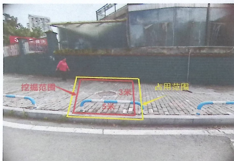
现场图⑥人行道:
